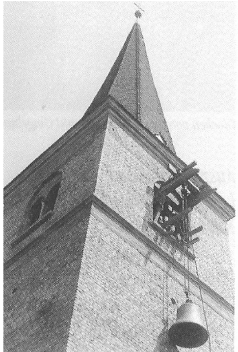
Einbau im Turm
